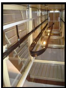
Modernizovaná šachta sklo
